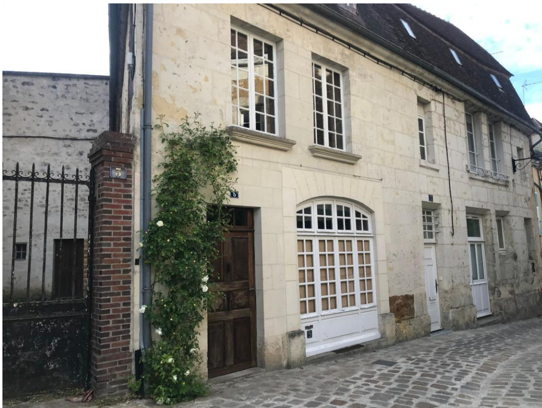
Façade du 5 rue de Toussaint, Mortagne-au-Perche
