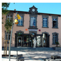
MÉDIATHÈQUE MUNICIPALE MAISON DES SAVOIRS
