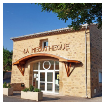
MÉDIATHÈQUE MUNICIPALE DE BOUTENAC
