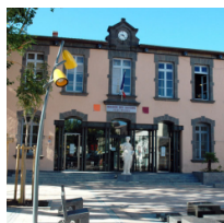
MÉDIATHÈQUE MUNICIPALE MAISON DES SAVOIRS
