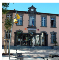
MÉDIATHÈQUE MUNICIPALE MAISON DES SAVOIRS
